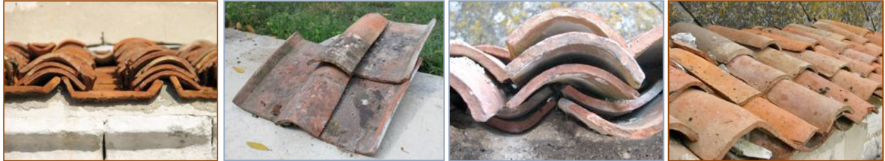
Vues ①② assemblage du type « romain » avec une imbrex (=plate) et une tegula Vues ③④ : couverture en tuile canal imbriquées, c'est le cas le plus fréquent.
